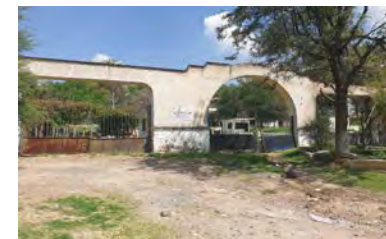
Acceso principal por carretera 45D al Ex -Relleno -Sanitario
