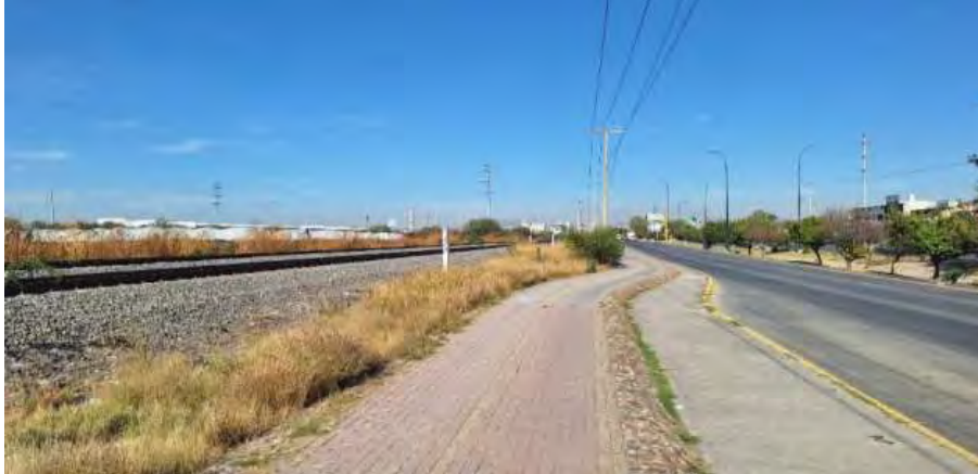
Fotografía 3 - Ciclovía, banqueta Sur del Blvd. Timoteo Lozano y vía del FFCC.
