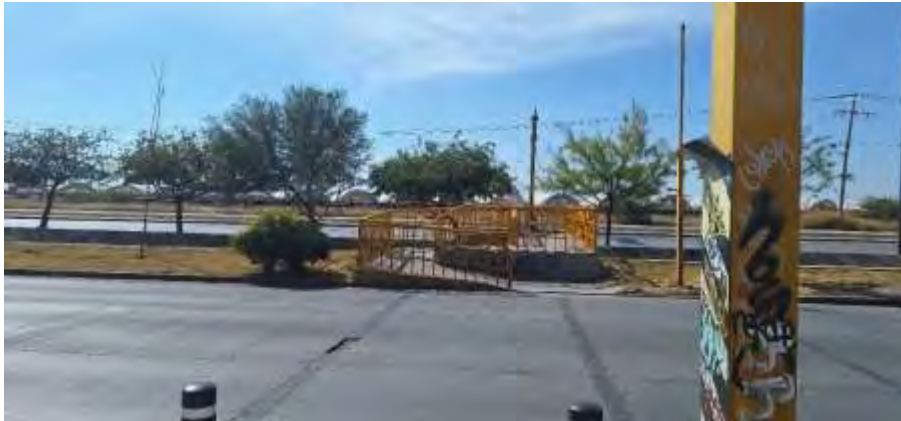
Fotografía 33 - Paso peatonal y presencia de grafiti.
