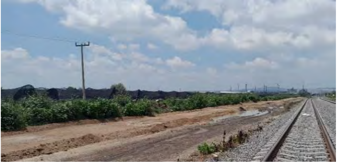
Imagen 7 - Vistas del predio del PMS desde la colindancia de la vía de ferrocarril.
