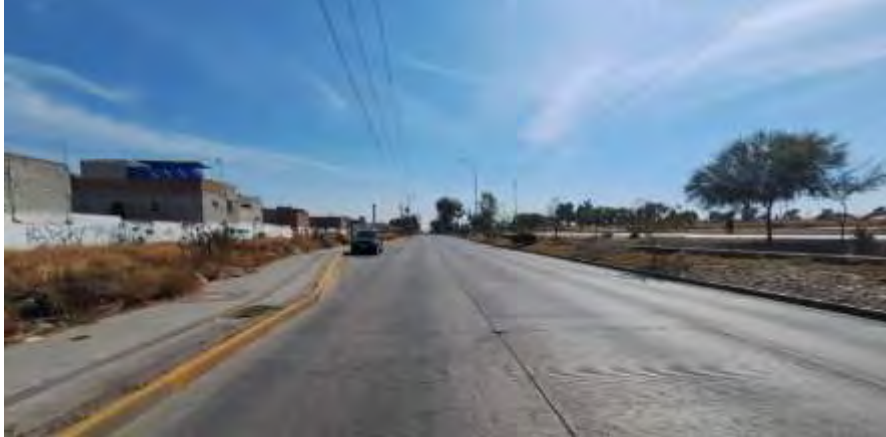
Fotografía 6 - Imagen general de cuerpo Norte del Blvd. Timoteo Lozano.
