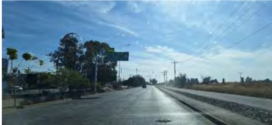
Fotografía 7 - Vista general de cuerpo Sur del Blvd. Timoteo Lozano.
