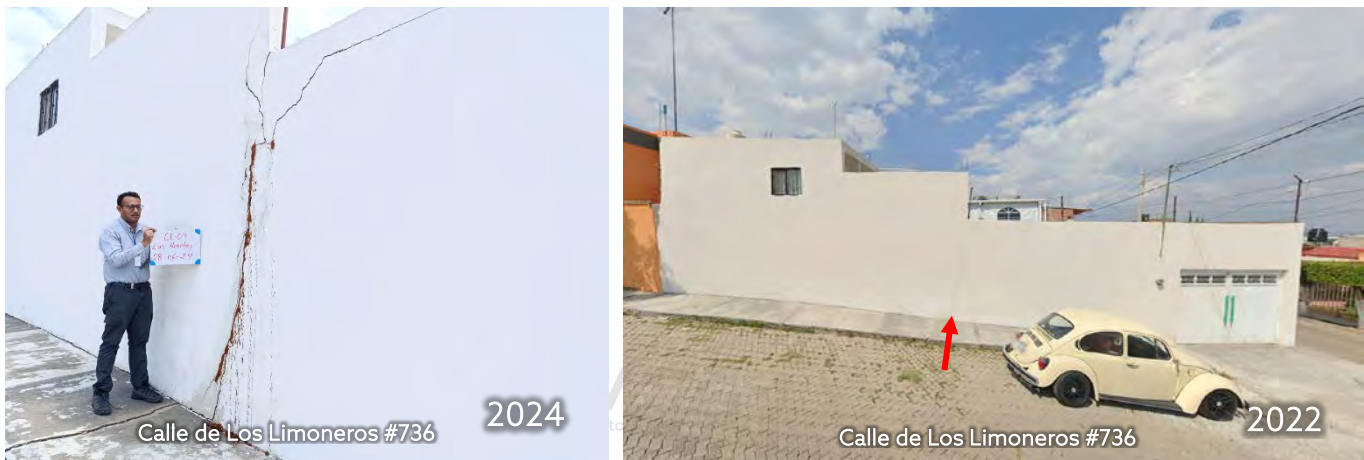
Figura 3.31. Fracturamiento del 2022 y 2024 para el punto CI-09. Fuente: Elaboración propia en recorrido de campo y de Google Maps.
