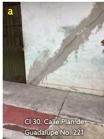
Figura 3.26. Fracturamiento a) en muros de vivienda y b) barda perimetral.
