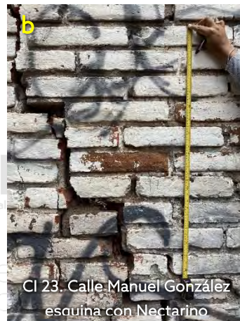
Figura 3.26. Fracturamiento a) en muros de vivienda y b) barda perimetral.
