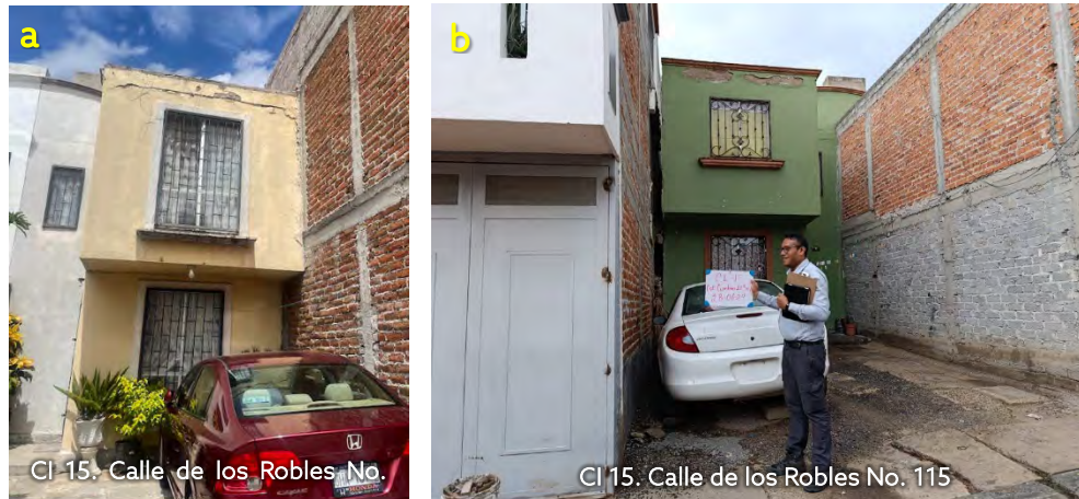
Figura 3.20. a) Recarga y b) apertura entre muros colindantes provocando esfuerzos laterales y fracturamiento horizontal.
