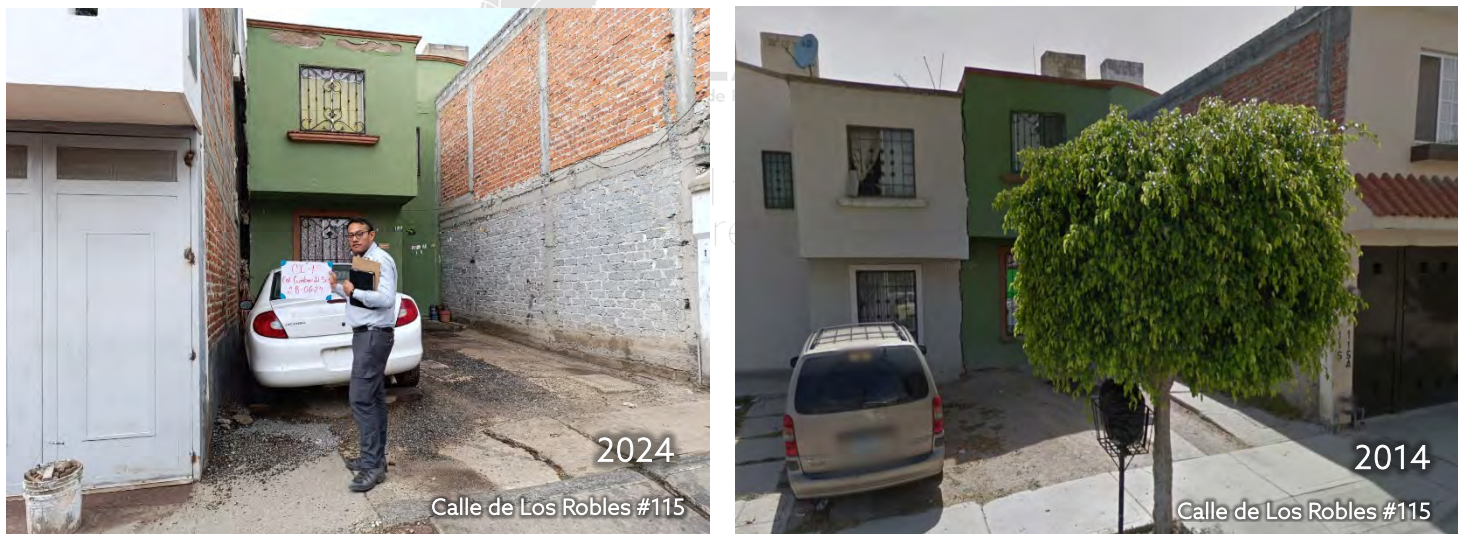
Figura 3.34. Separación entre muros divisorios del 2022 y 2024 para el punto CI-15. Fuente: Elaboración propia en recorrido de campo y de Google Maps.
