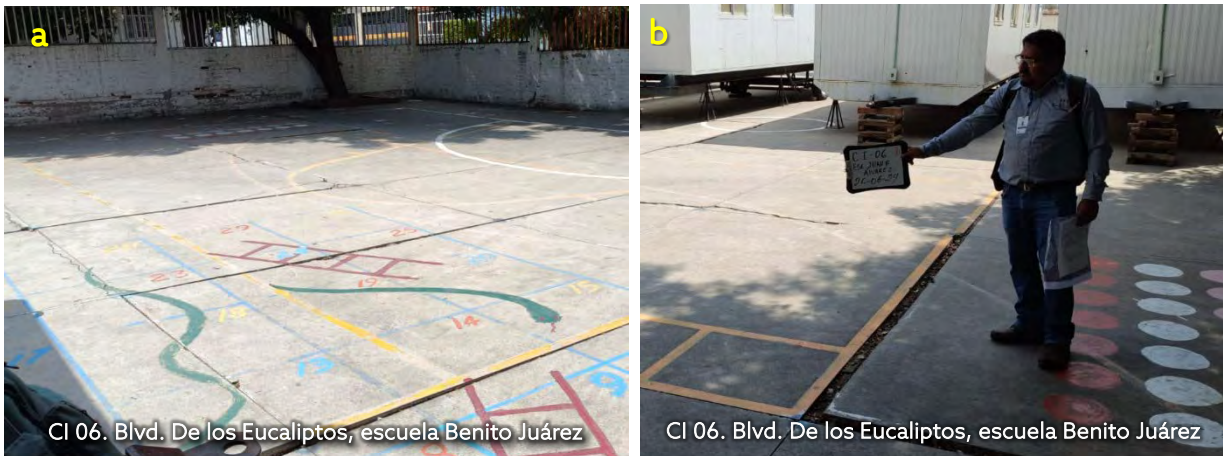
Figura 3.13. a) Dislocamiento de bloques de concreto y b) separación de bloques de concreto. Fuente: Elaboración propia en recorrido de campo.
