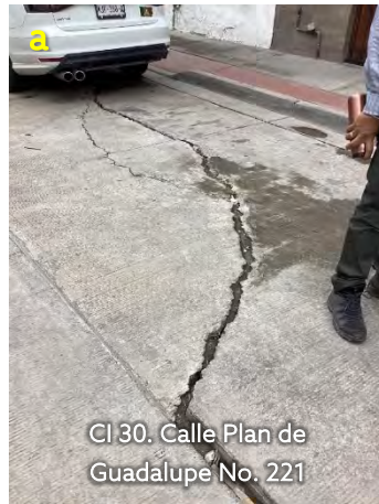
Figura 3.25. a) Fracturamiento y separación de bloques de pavimento y b) hundimiento e inclinación de barda.
