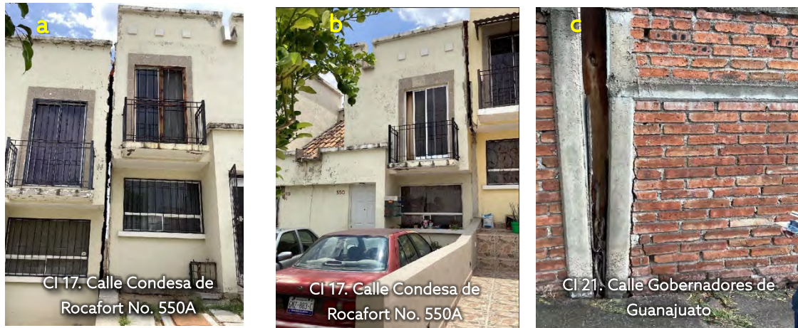
Figura 3.24. Apertura de a) muros de colindancia y b) barda perimetral. Fuente: Elaboración propia en recorrido de campo.
