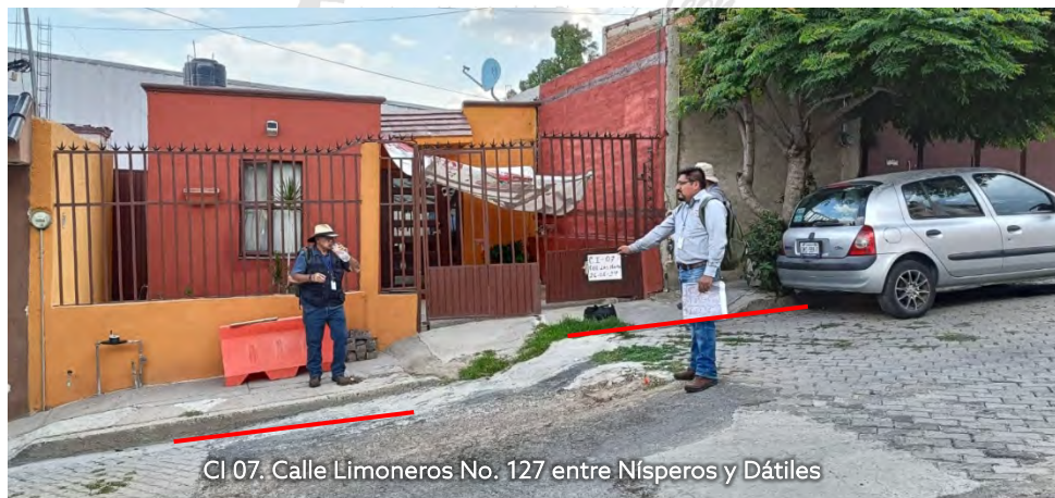
Figura 3.14. Hundimiento de 45 cm. Fuente: Elaboración propia en recorrido de campo.
