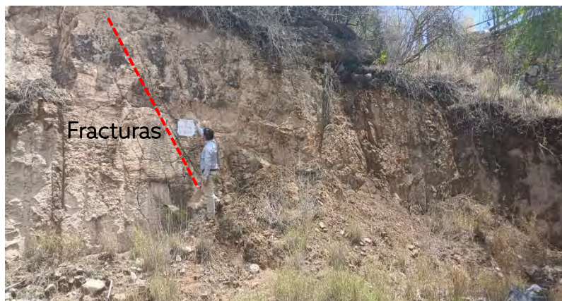
Figura 3.3. PVG-3, en la colonia Las Huertas Fuente. Elaboración propia en recorrido de campo
