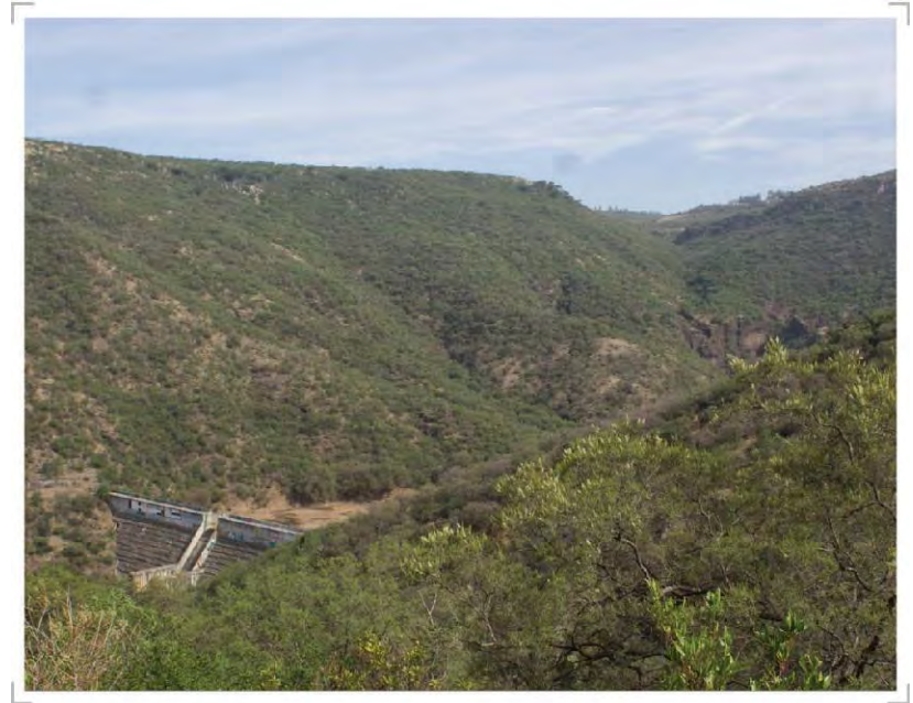
Imagen 34. Vista del lado Noreste de la cañada, en la parte inferior se identifica la presa de laManzanilla
