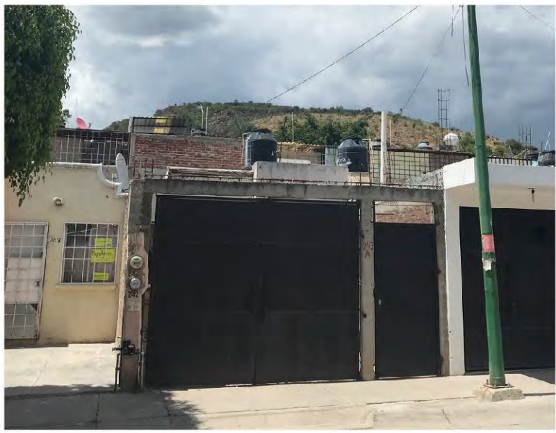
Imagen 53. Al Noreste colindando con el ejido, se encuentra viviendas, vialidades y equipamiento urbano en mejores condiciones
